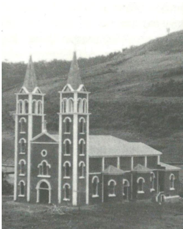
Primeira fotografia da Igreja Matriz, uma vez concluídos os trabalhos de construção.
