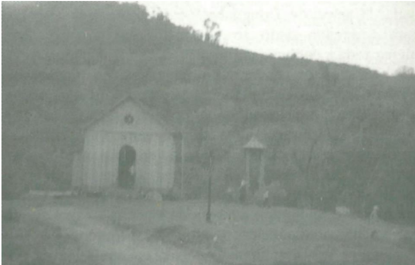
Nossa Senhora Assunta ao Céu foi entronizada Padroeira de Linha Conte, anteriormente denominada Linha Barra do Veloso. Na foto, a primeira Capela da Comunidade erguida pelos pioneiros.
