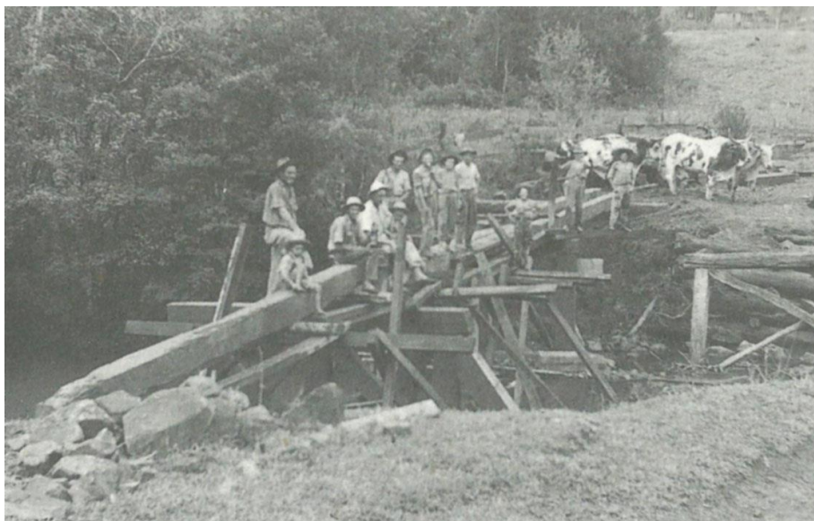
Construção de ponte sobre o Rio São Bento.
