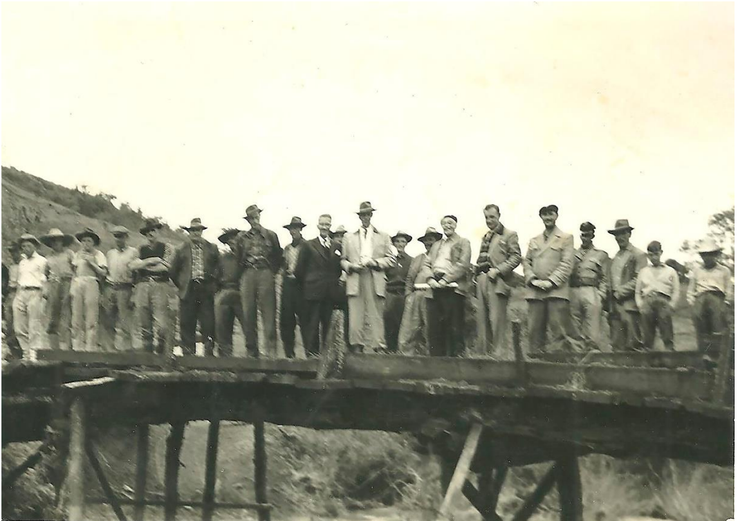
Primeira ponte construída sobre o Rio Santo Antonio, no então Distrito do Veloso.
