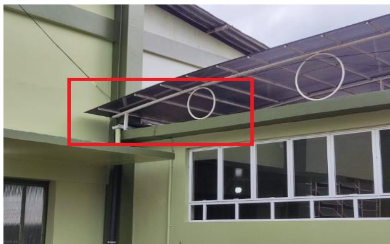
Foto 02 – Ampliação da calha coletora de água
