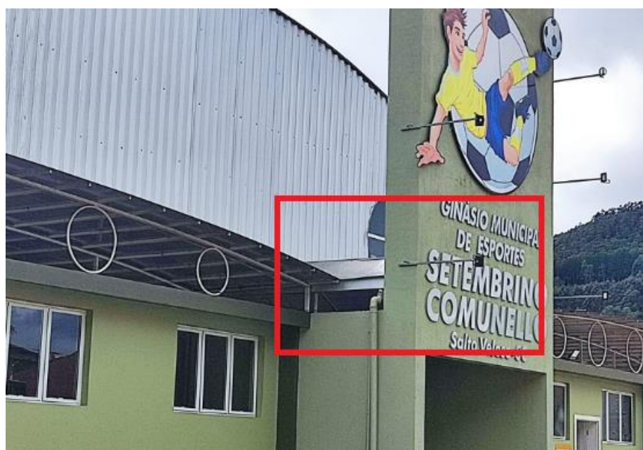
Foto 05: Interligação central entre as coberturas
