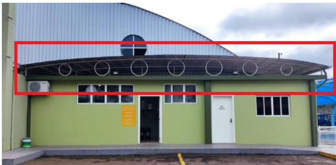
Foto 03: Lado direito da cobertura
