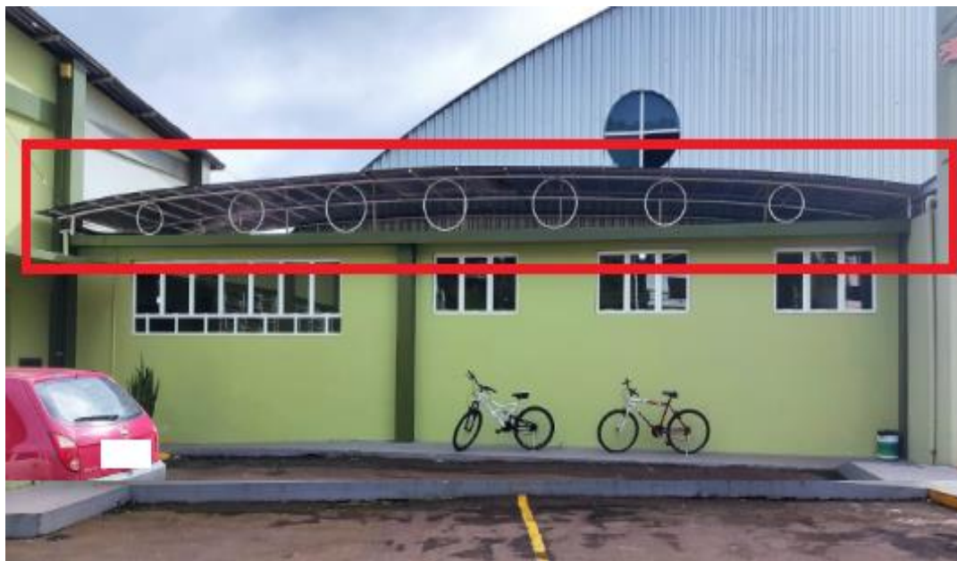
Foto 04: Lado Esquerdo da Cobertura
